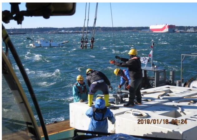
固定金具をセンターに入れ 吊金具へ玉掛フックを掛け玉掛
